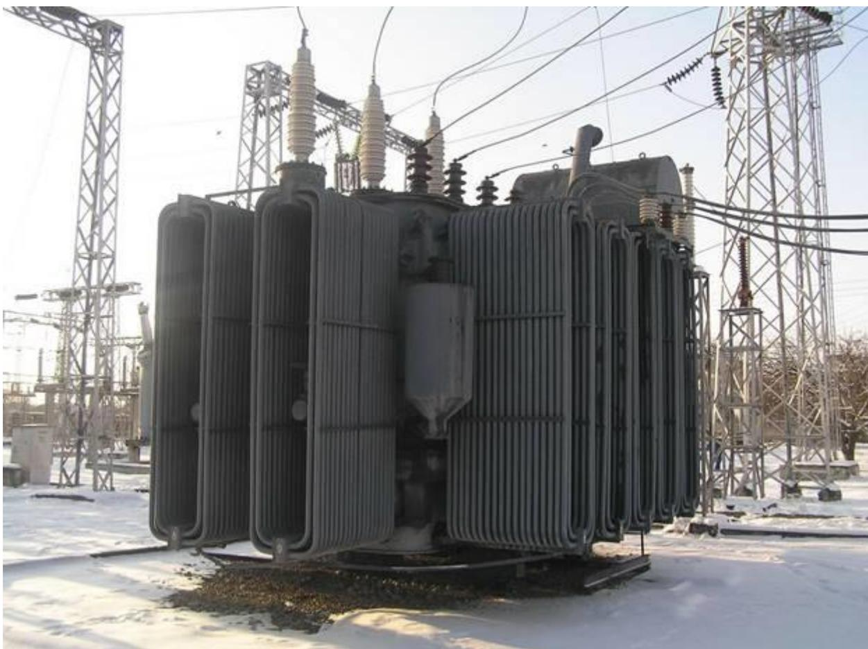
Впервые трансформаторы были использованы в 1878 году русским учёным П.Н. Яблочковым для питания изобретённых им электрических свечей. Простейший трансформатор состоит из сердечника замкнутой формы из магнито-мягкого материала, на который намотаны две обмотки: первичная и вторичная (смотри рис.)
